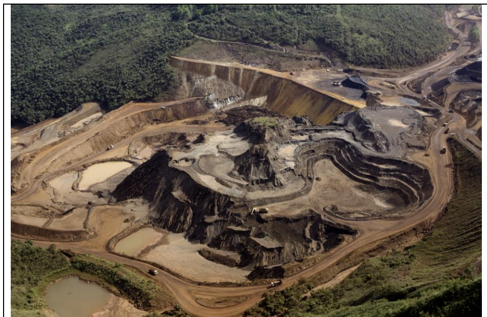
Fig. 08 - Foto aérea de exploração mineral da Itaminas Comercio de Minério.
